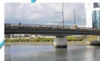
室見川筑肥橋付近
