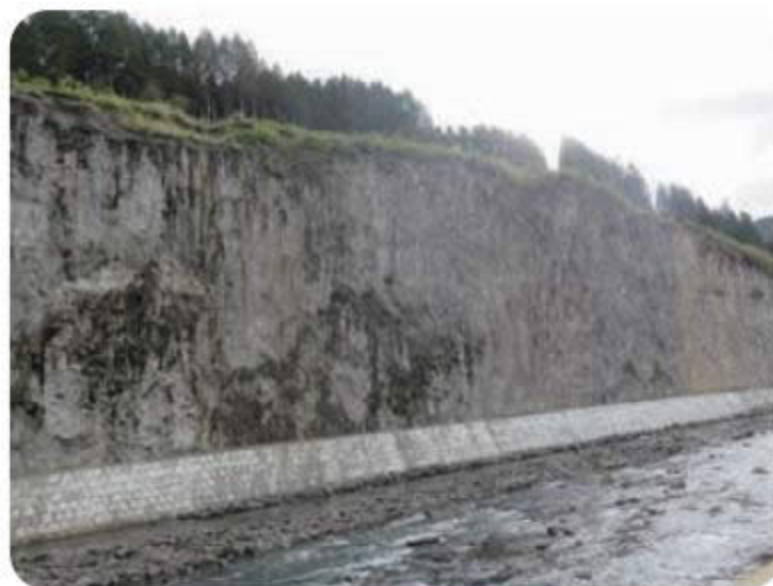
【山ノ釣工区の法面復旧状況】
