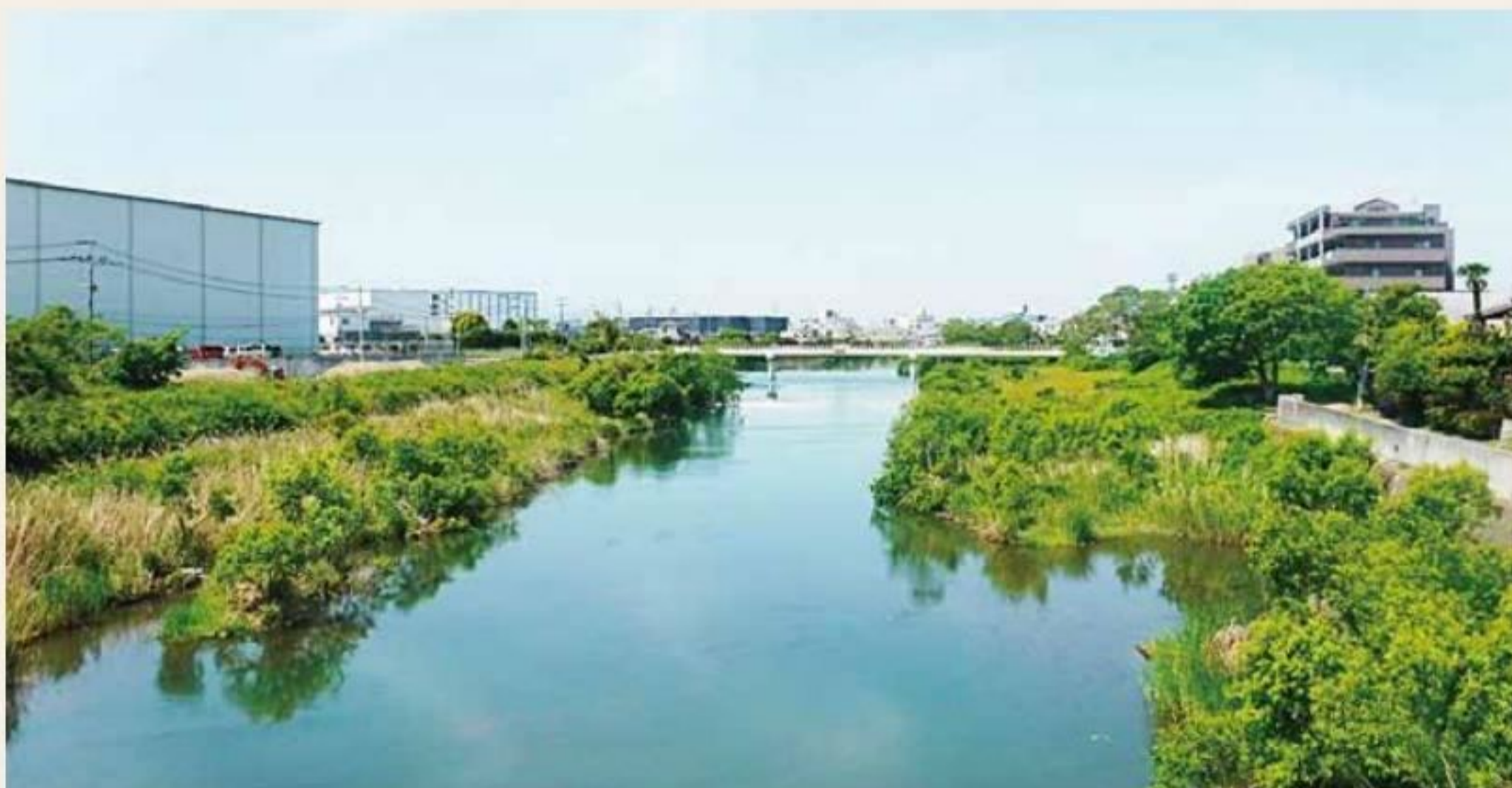
多々良川 雨水橋下流(粕屋町大字江辻付近)
