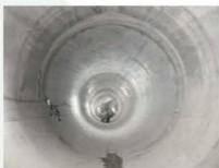
地下河川内部写真
