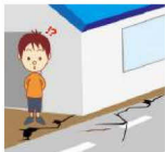
地面のひび割れ
