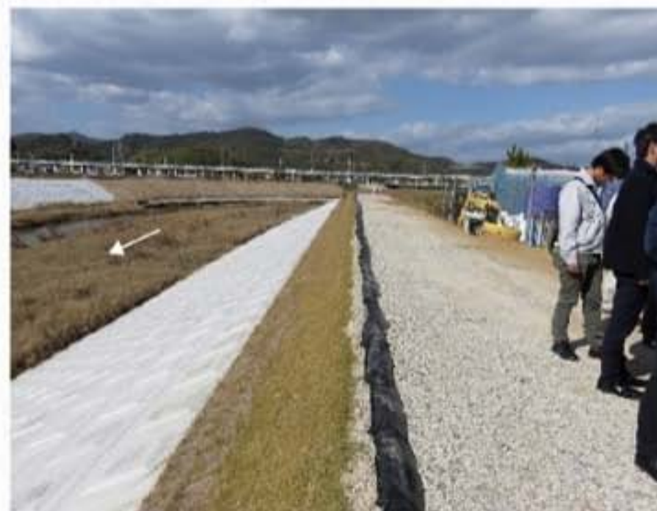
【砂川の決壊箇所の復旧状況】
