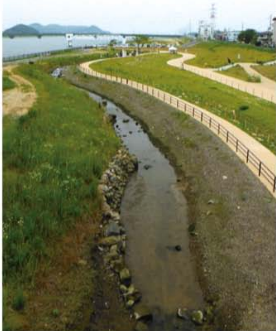
遠賀川河口堰の魚道
