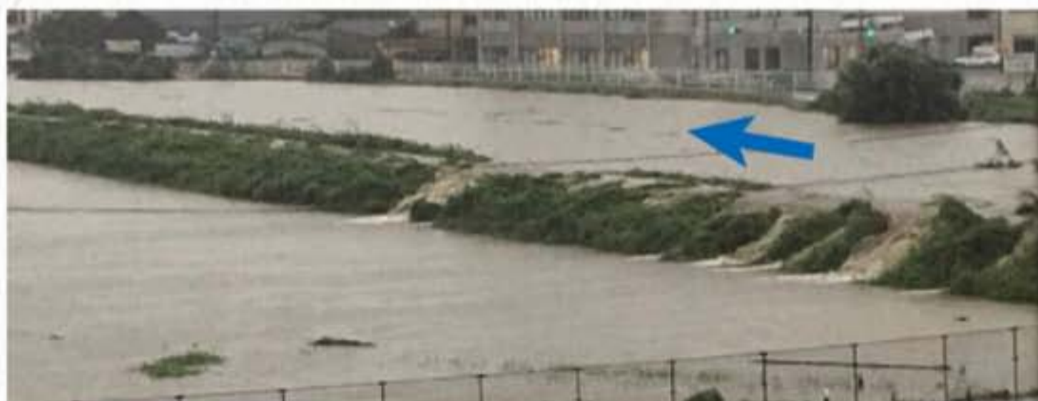
H30.7 浸水被害状況
