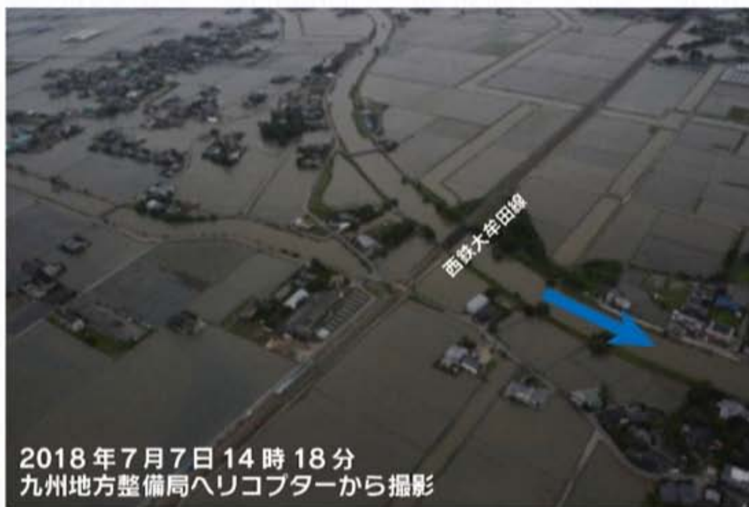
H30.7 浸水被害状況
