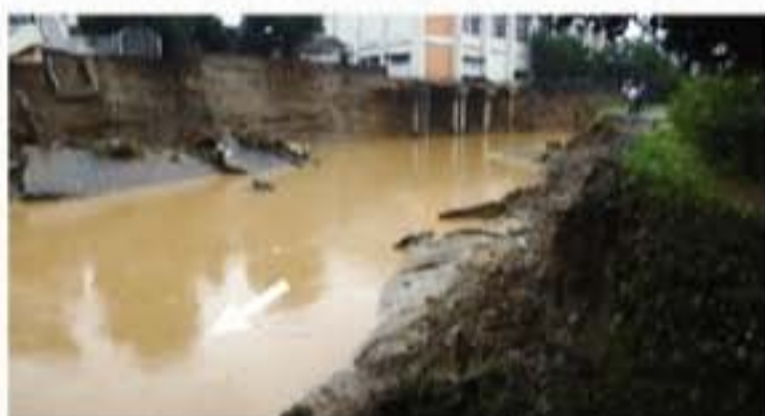
桂川(朝倉市)被災状況
