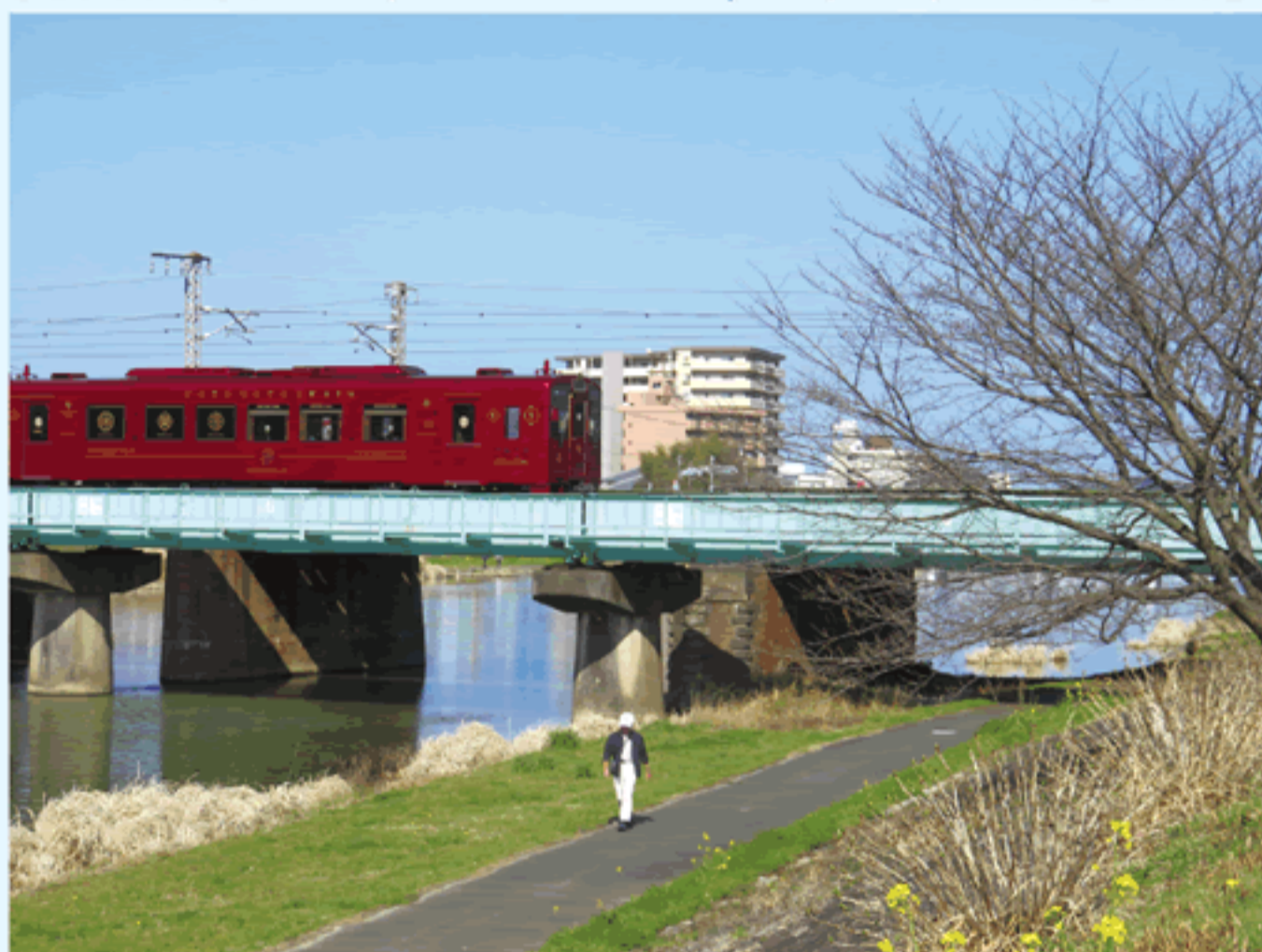
■撮影時期:2019年3月 ■撮影地:行橋市西宮市 ■撮影者:Kitagawa, E
