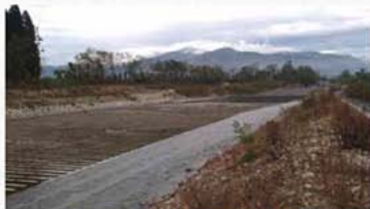
【斉内川に再整備された床止めと魚道】
