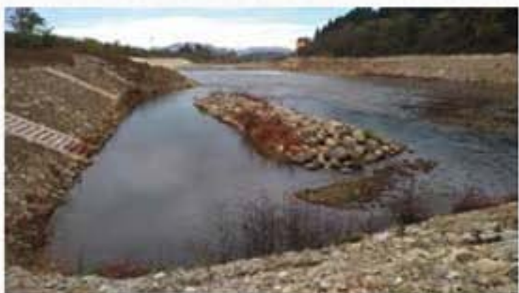
【床止めの下流端に設置されたワンド】
