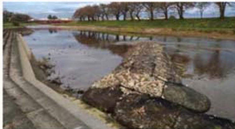
視察の途中では、県職員の方と地元の方が協力して設置したバープ工(寄り洲を形成するための水制の一種)も見ることができました。
