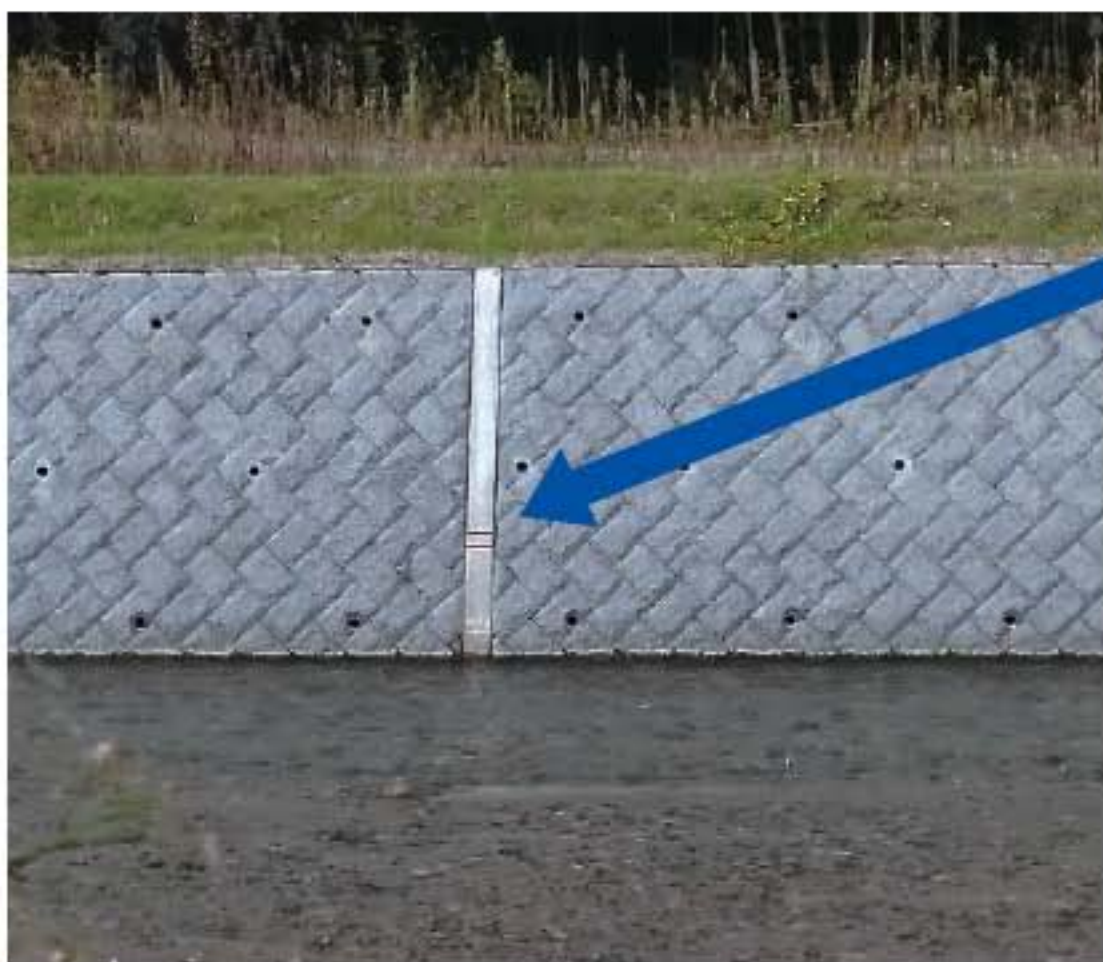
【鴨川(小口止め):高島市】
