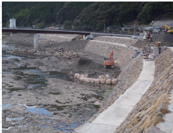
皆瀬工区から皆瀬橋方面
