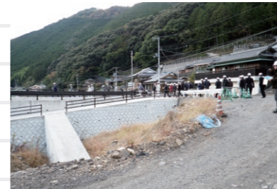
皆瀬橋付近の家(屋根付近まで水位が上昇)
