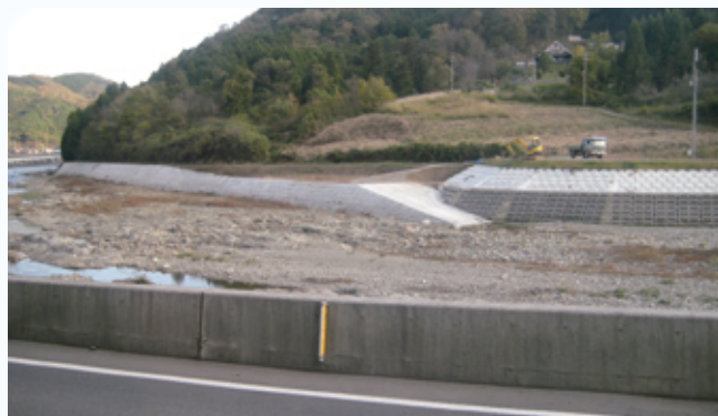
吉野川河川災害復旧等関連緊急事業現場
