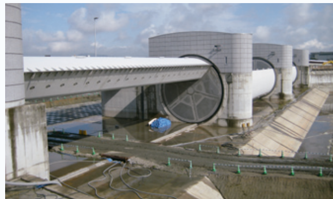
百間川河口水門増築事業現場
