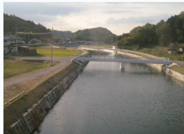
山家川河川災害復旧助成事業現場
