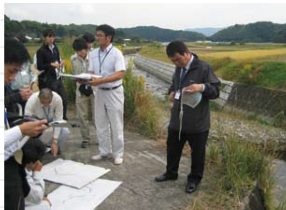
海老川河川災害復旧現場
