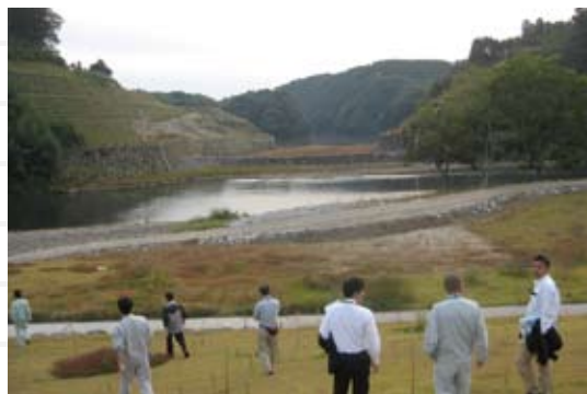
川内川推込分水路(さつま町屋地地区)
