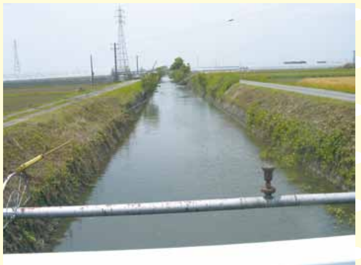
コンクリート化された水路
