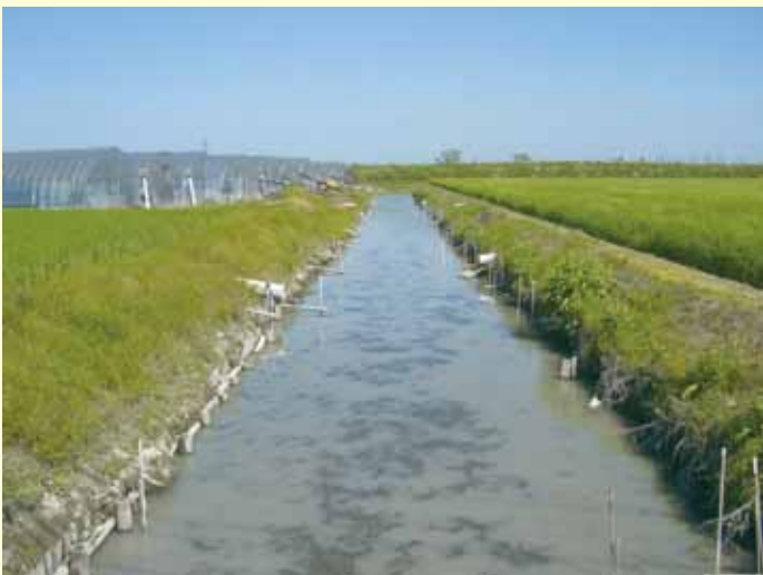
古い木柵工水路
