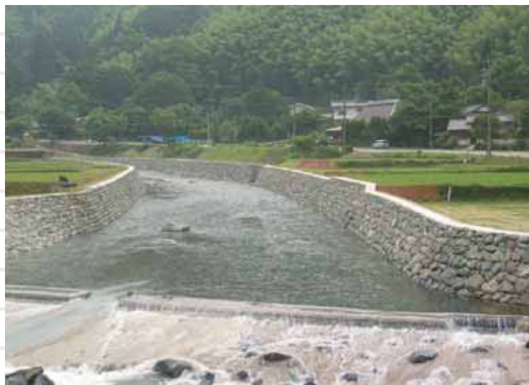
自然石を使った復旧状況
