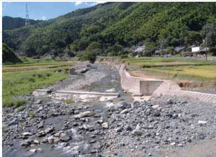
護岸が崩壊した被災状況
