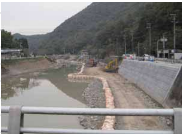
佐用川(久崎地区)工事の様子
