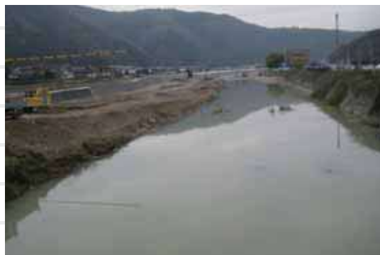
佐用川(真盛地区)二線堤予定箇所
