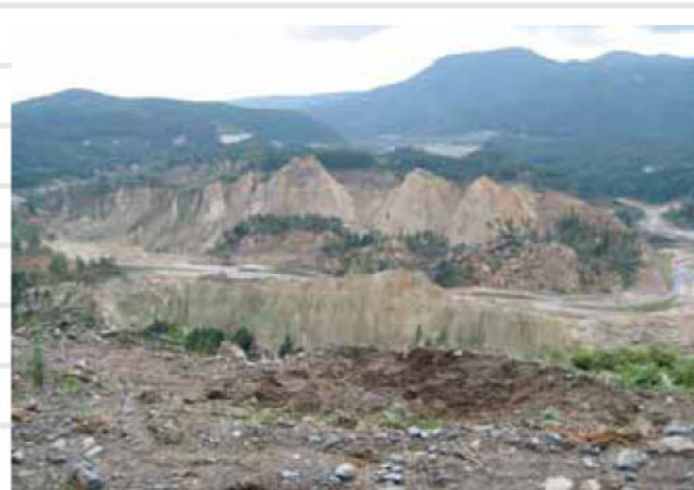
二迫川上流で発生した荒砥沢地すべり
