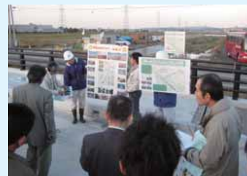
猿橋川助成事業現場(稲葉川放水路部)
