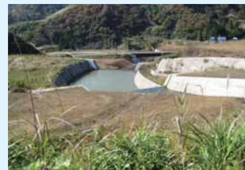
東竹沢(芋川)地区大規模河道埋塞復旧現場
