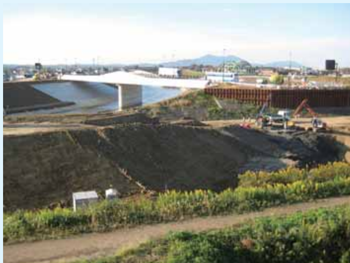
刈谷田川助成事業現場(中之島ショートカット部)
