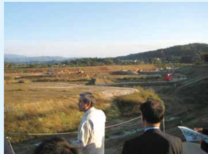
刈谷田川助成事業現場(遊水池部)
