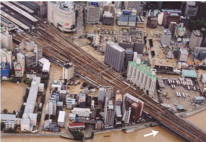
博多駅周辺の出水状況
