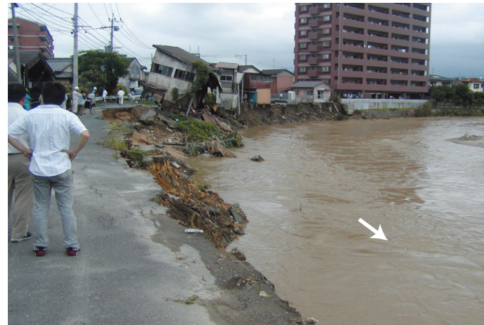
被害状況(東那珂三丁目)
