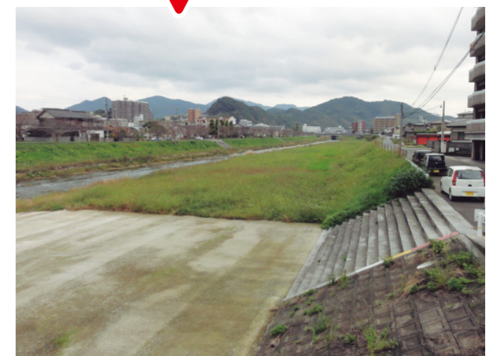
アユの放流イベント会場(整備後)
